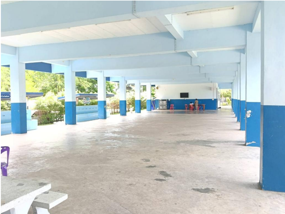
จุดที่ ๒ ใต้ถุนอาคารเรียน ๗
