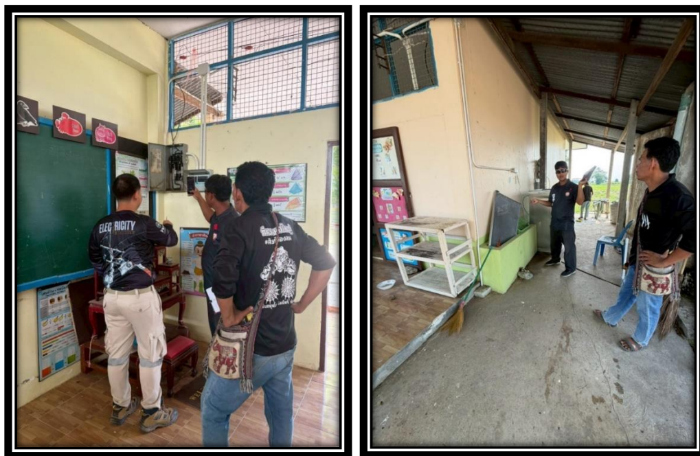
ภาพการดำเนินการตรวจ ซ่อมแซม ระบบไฟฟ้าในสถานศึกษา
