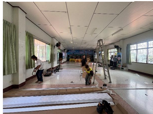
ซ่อมแซมสายไฟที่ชำรุดให้พร้อมใช้งาน
