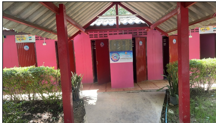
โรงเรียนมีน้ำดื่มสะอาด ห้องน้ำ จุดล้างมือที่ถูกต้องลักษณะ
