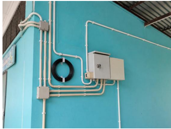
ภาพที่ 2 ตรวจสอบระบบไฟฟ้า สายไฟ และตู้ควบคุมให้อยู่ในสภาพเรียบร้อย
