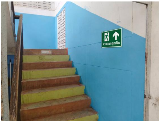
ภาพที่ 3 ติดตั้งป้ายทางออกฉุกเฉินและกำหนดเส้นทางหนีภัยอย่างชัดเจน
