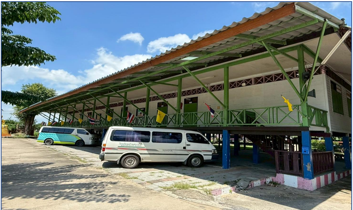
ตรวจสอบสภาพพื้นที่ อาคาร สถานที่ ให้มีความมั่นคง แข็งแรง และปลอดภัยต่อการจัดกิจกรรม
