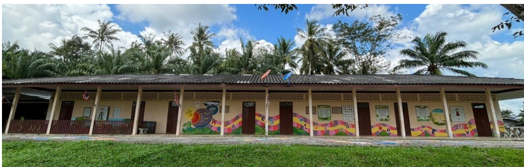
อาคาร ป.1 ก
