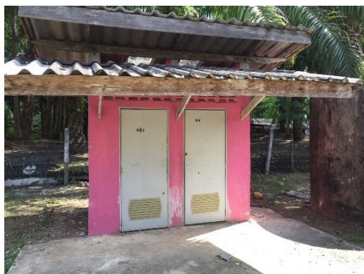
ห้องน้ำ 2 ห้อง
