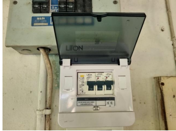
ติดตั้งเบรกเกอร์ตู้กั้นน้ำดื่ม เพื่อป้องกันอันตรายจากกระแสไฟฟ้า
