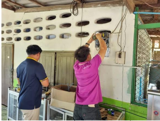
ติดตั้งเบรกเกอร์ตู้กั้นน้ำดื่ม เพื่อป้องกันอันตรายจากกระแสไฟฟ้า
