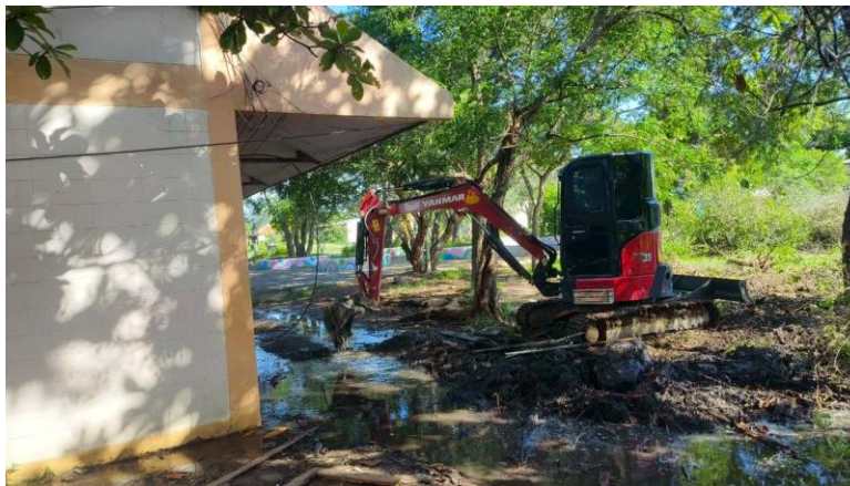
ขุดลอกท่อเนื่องจากทำให้เกิดน้ำขังช่วงฝนตก
