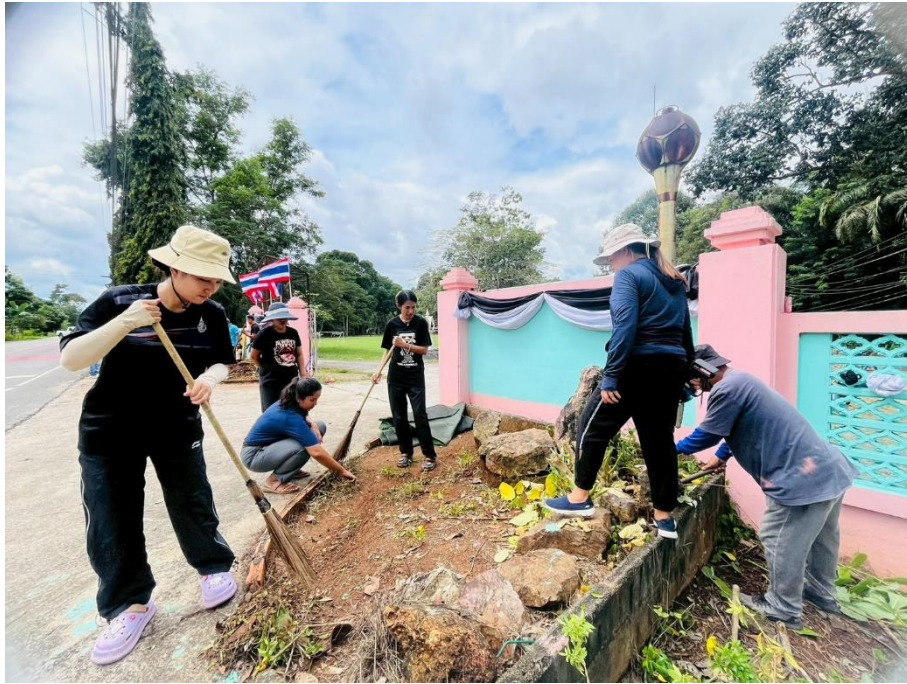
ภาพ .ซ่อมแซมสวนหน้าโรงเรียน
